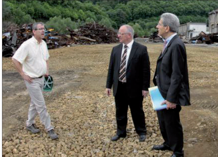
Jacques Loiselot, chargé d'opération à l'EPFL, explique le déroulement du chantier de démantèlement d'Europipe.
