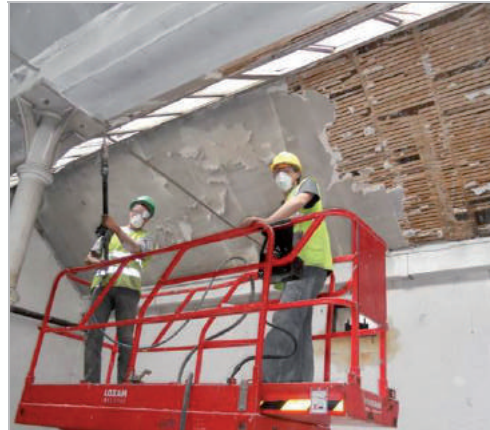
L'opération est délicate : il faut tout d'abord enlever le plâtre avant de s'attaquer au lattage en bois.
