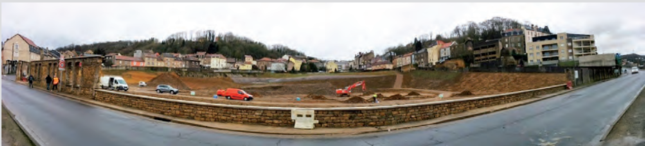
Longwy / Rehon – Ancienne briqueterie (Friche Didier)
