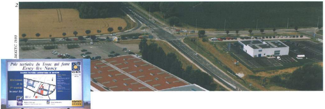
1. La Maxe (57): implantation en cours de l'entrepôt et du magasin Ikea 2. Essey-lès-Nancy (54): la Z.A.C. du "Tronc qui fume"
