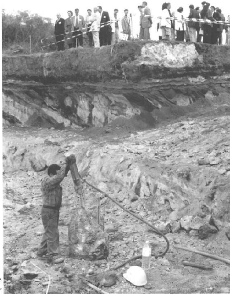
Pompey (54): visite de chantier
