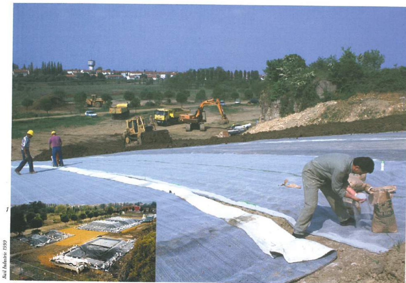
Homécourt (54): site de la cokerie - 1. essai pilote de biotraitement sur des terres polluées 2. imperméabilisation de la zone d'anciens réservoirs à goudron
