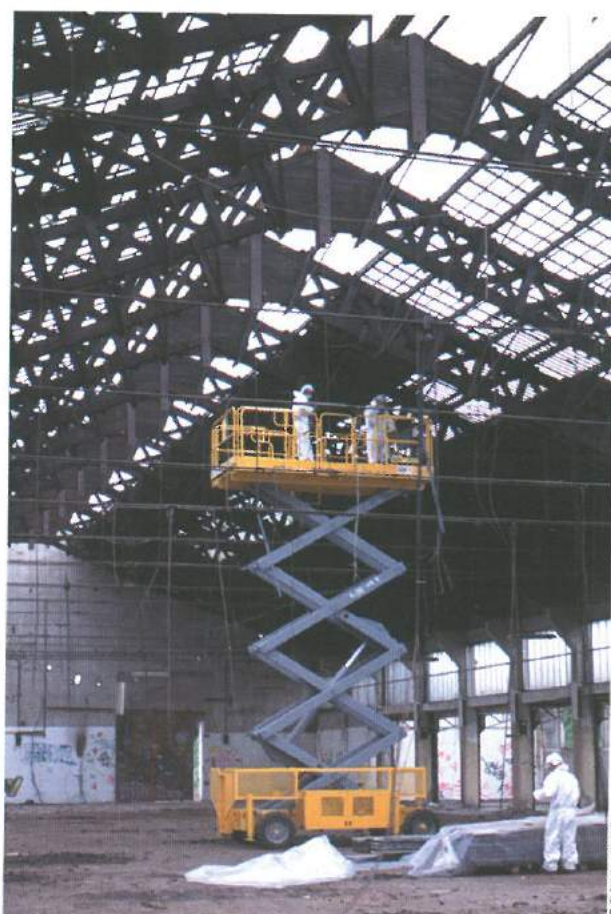
Metz (57): désamiantage sur le chantier de l'ex-Foire Internationale
