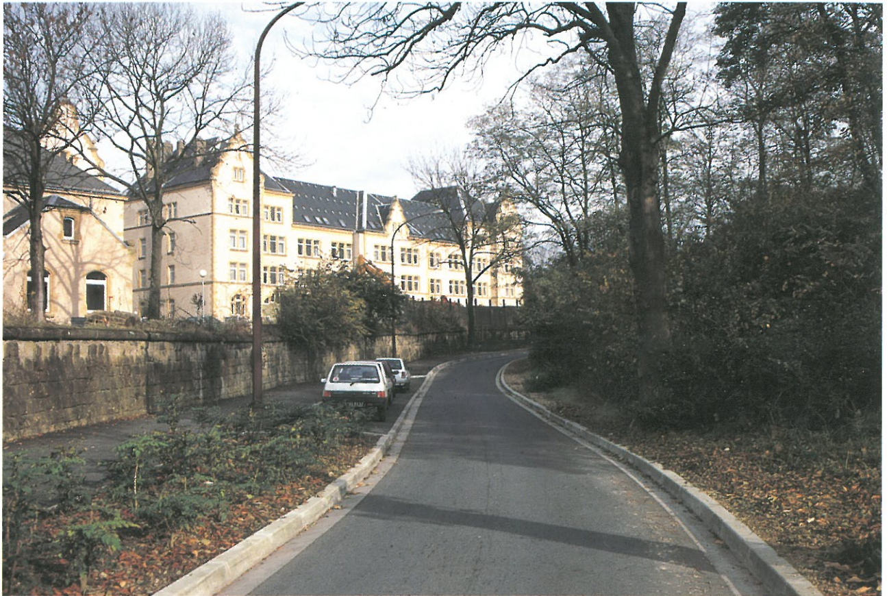
Ancienne caserne Bridoux à Metz.
