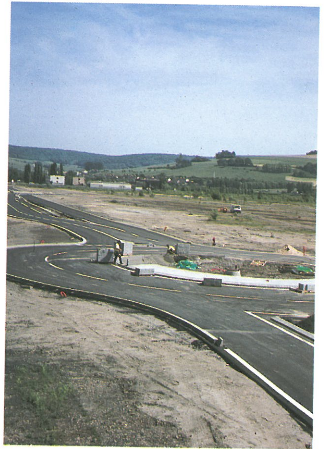
Parc d'Activités de Nancy-Pompey réalisation d'une voirie.
