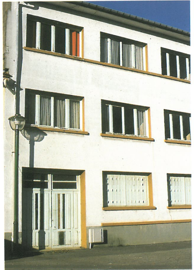
Logements d'insertion à Saulxures-lès-Nancy.
