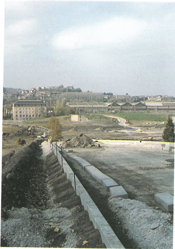
Parc International d'Activités des 3 frontières - réalisation du Barreau Sud.
