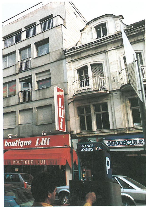
Zone d'Aménagement Concerté de la ville haute à Forbach.
