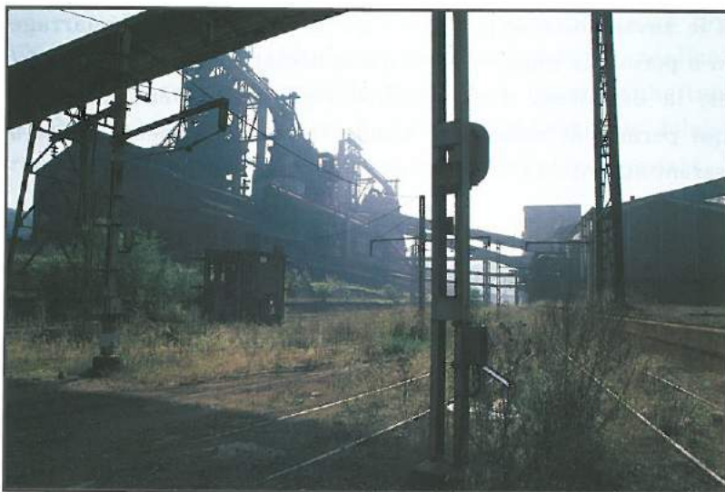
Bassin sidérurgique : Site de l'ancienne usine de Joëuf- Moyeuvre (54-57).
