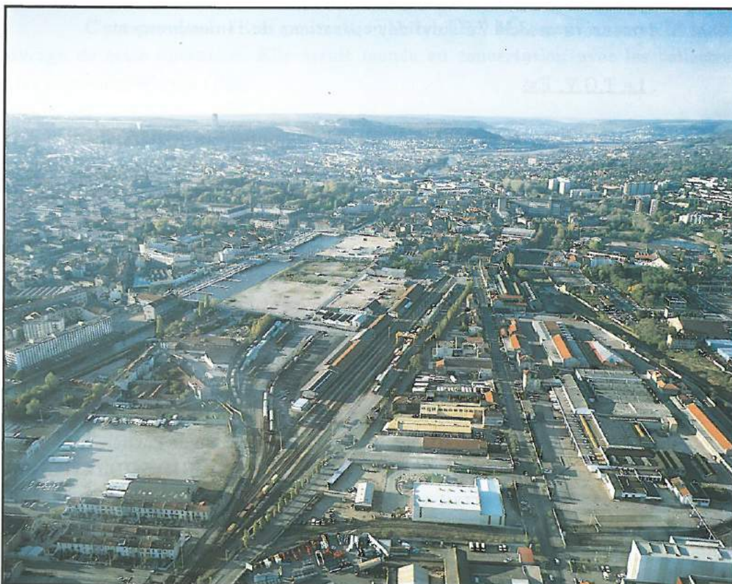
Le faisceau de voies désaffectées de la gare Saint-Georges à Nancy
