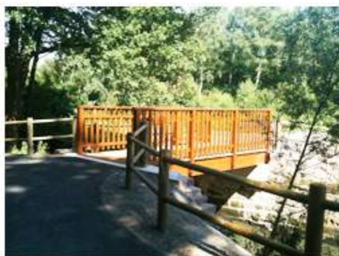
PASSERELLE SUR LA ROSSELLE
