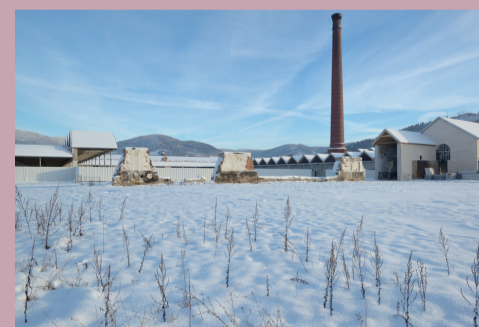
Fraize - Malora / Pôle écoconstruction
