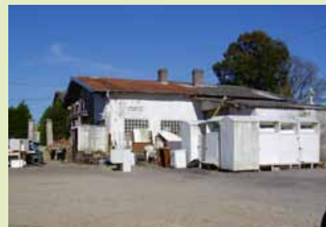
La requalification de l'ancienne laiterie à BOVEE SUR BARBOURE
