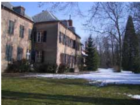
Des travaux de démolition et de clos couvert sur bâtiment inscrit sur le site des SALINES ROYALES à DIEUZE
