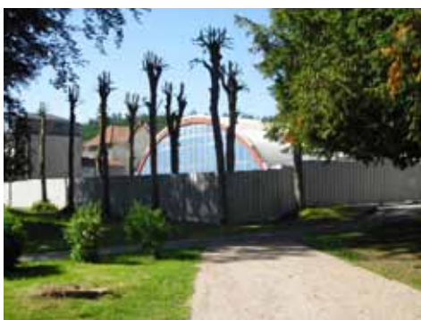
Le désamiantage et la déconstruction du gymnase rue PONSCARME – Site VIVIANI à EPINAL
