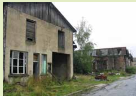
La requalification de l'ancienne faïencerie de BADONVILLER
