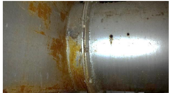
P52 – vers conduit de fumée
