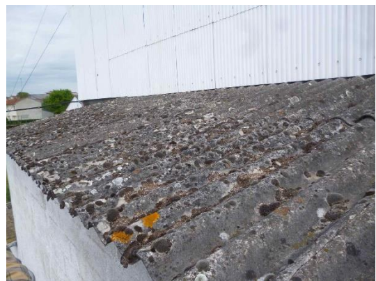
P33 – Garage à côté chaufferie
