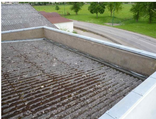
P34 – Au-dessus du dégt du 1 er étage
