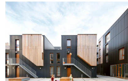
Réhabilitation d'une ancienne savonnerie, Bruxelles
