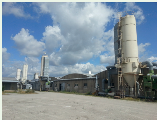
Bâtiments industriels sur le site de Treize-Septiers (85)
