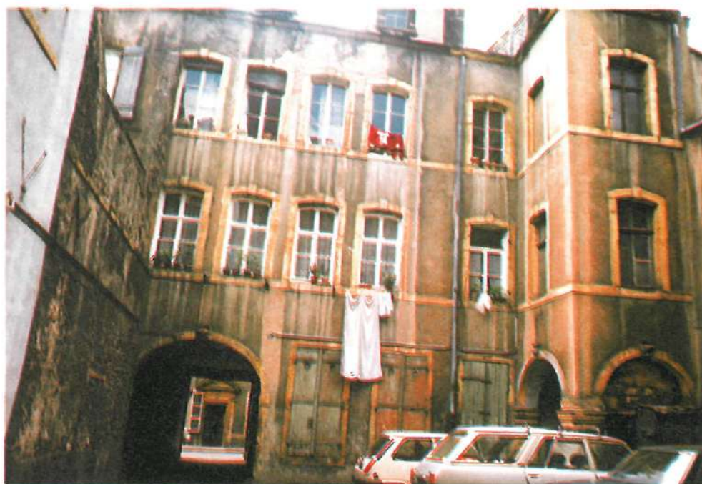
QUARTIER OUTRE SEILLE A METZ : VUE D'UN IMMEUBLE GERE PAR L'EPML
