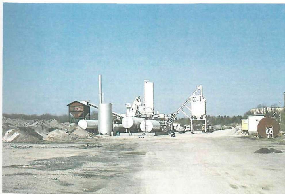
VUE D' UNE STATION D' ENROBAGE MAINTENUE SUR LE SITE
