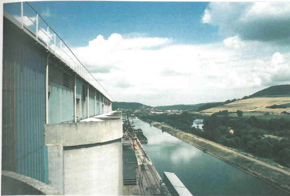
AMENAGEMENT DE LA MEURTHE VUE DU PORT DE FROUARD
