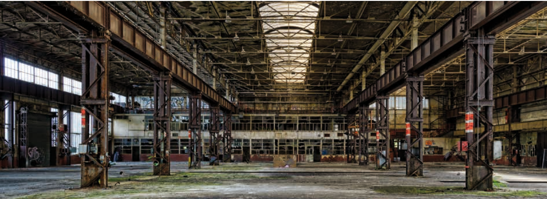
Amnéville/Rombas - Site Sollac
